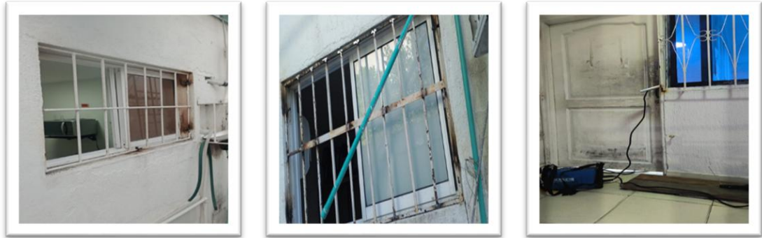
Ilustración 38. Registro fotográfico intervención San Vicente de Paul
