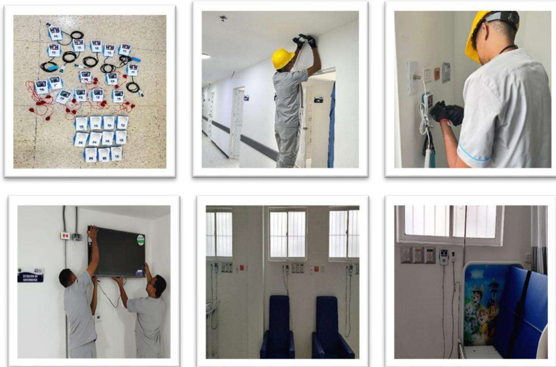
Ilustración 41. Registro fotográfico instalación de sistemas de llamadas
