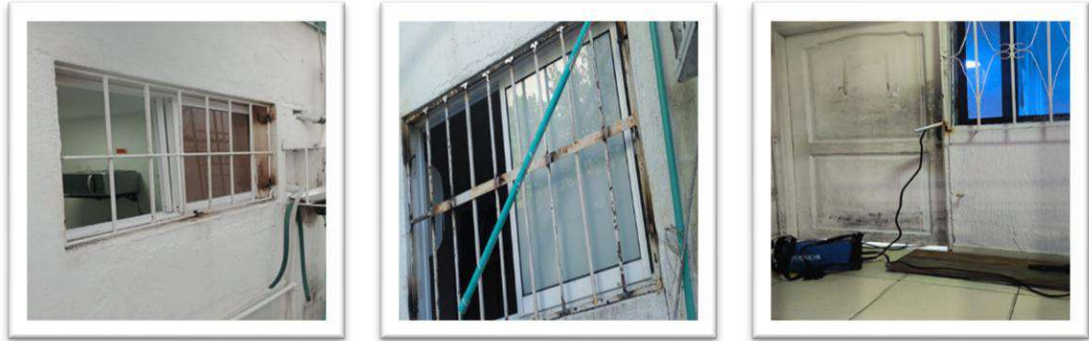
Ilustración 38. Registro fotográfico intervención San Vicente de Paul
