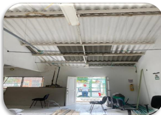
(Imágenes del antes y después de cambio de láminas en cubierta y cambio de tubería)
